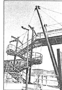
Passerella pedonale di via Campana sulla linea Ferroviaria
