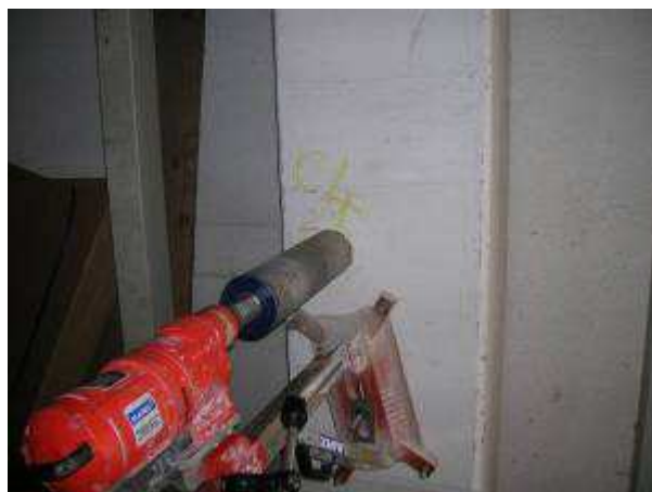
Fig. 1 Strumento utilizzato per il carotaggio.
