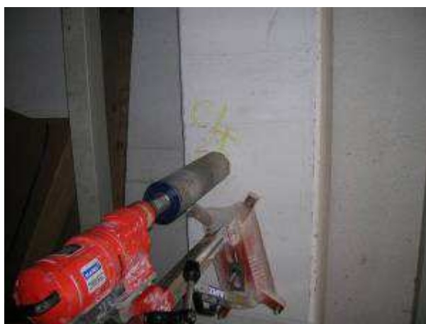
Fig. 1 Strumento utilizzato per il carotaggio.
