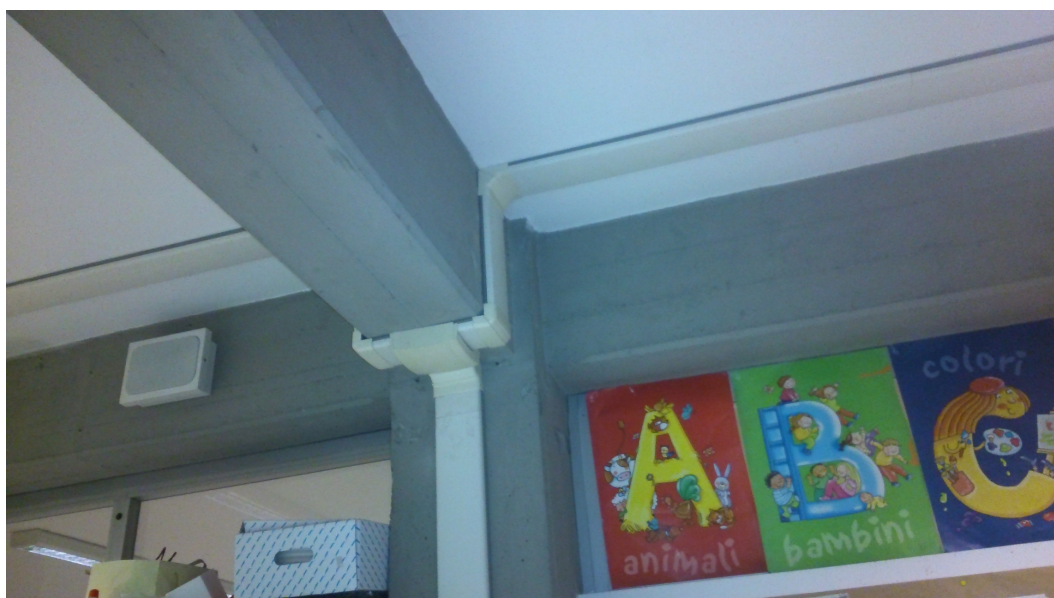
Dettaglio piano primo: canaline elettriche in parete e a soffitto
