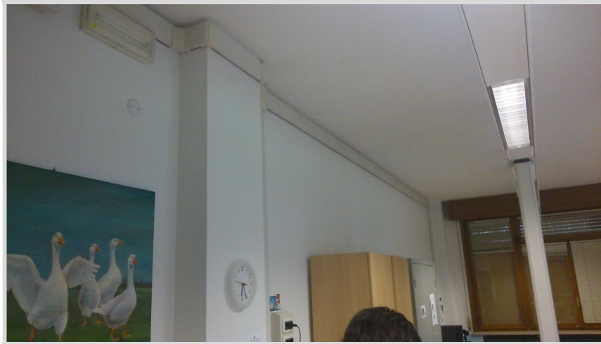
Figura 17: Piano rialzato: canaline elettriche e punti luce
