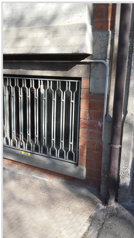
Figura 10 – Tubazioni illuminazione in corrispondenza del primo solaio della facciata ovest del corpo Ovest
