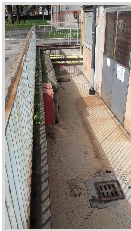
Figura 18 – Zona a livello del piano seminterrato a sud del corpo Ovest: presenza di caditoie per la raccolta dell'acqua della pavimentazione, di condotte gas sul muro di contenimento perpendicolare al fabbricato, e di elementi dell'impianto antincendio (in rosso)
