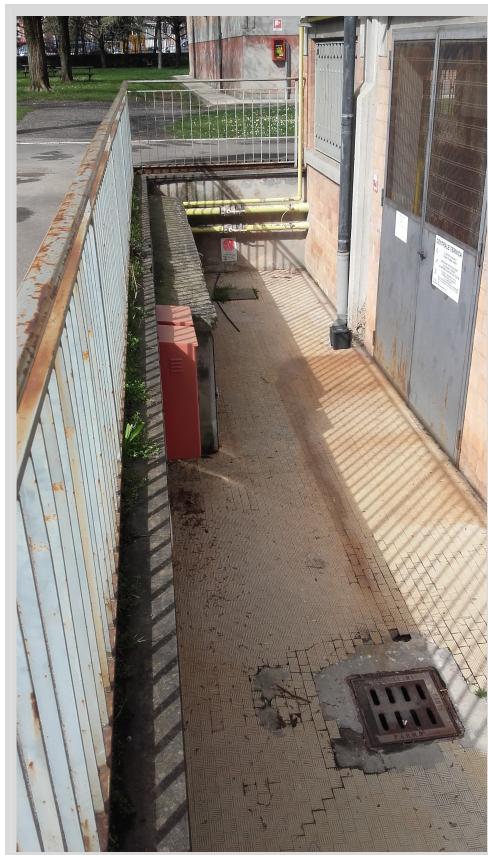
Figura 7 – Zona a livello del piano seminterrato a sud del corpo Ovest: presenza di caditoie per la raccolta dell'acqua della pavimentazione, di condotte gas sul muro di contenimento perpendicolare al fabbricato, e di elementi dell'impianto antincendio (in rosso)
