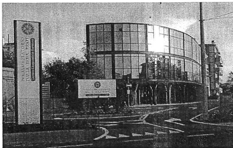
Foto – Vista da via Emilia Ovest. Facciate continue con elementi strutturali in vista. Portico con colonne ad arco tripartite ad albero.
