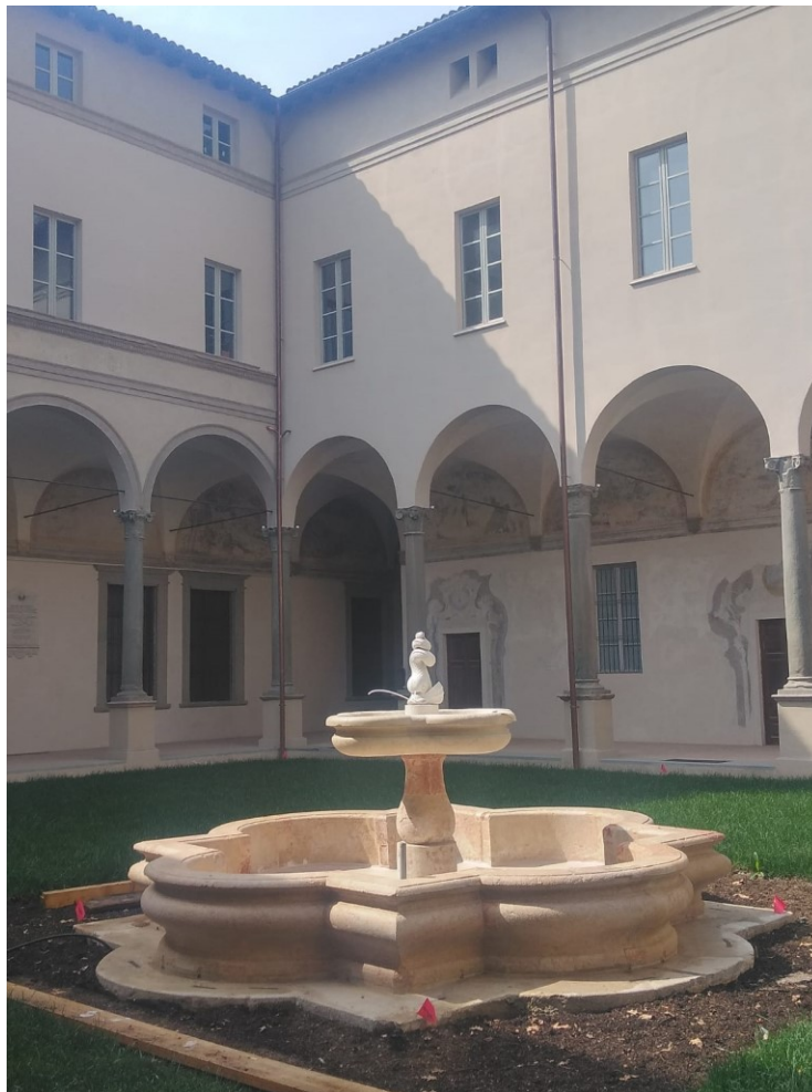
(Parma, "chiostro della fontana" del complesso monumentale del San Paolo)
